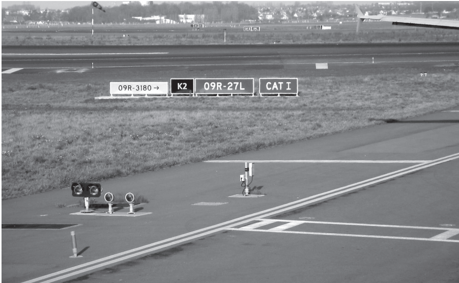
Joillain kentillä on lisätty normaalien rullaustievalojen lisäksi retro reflectoreja rullausteiden ja jopa kiitoteiden reunoille.
